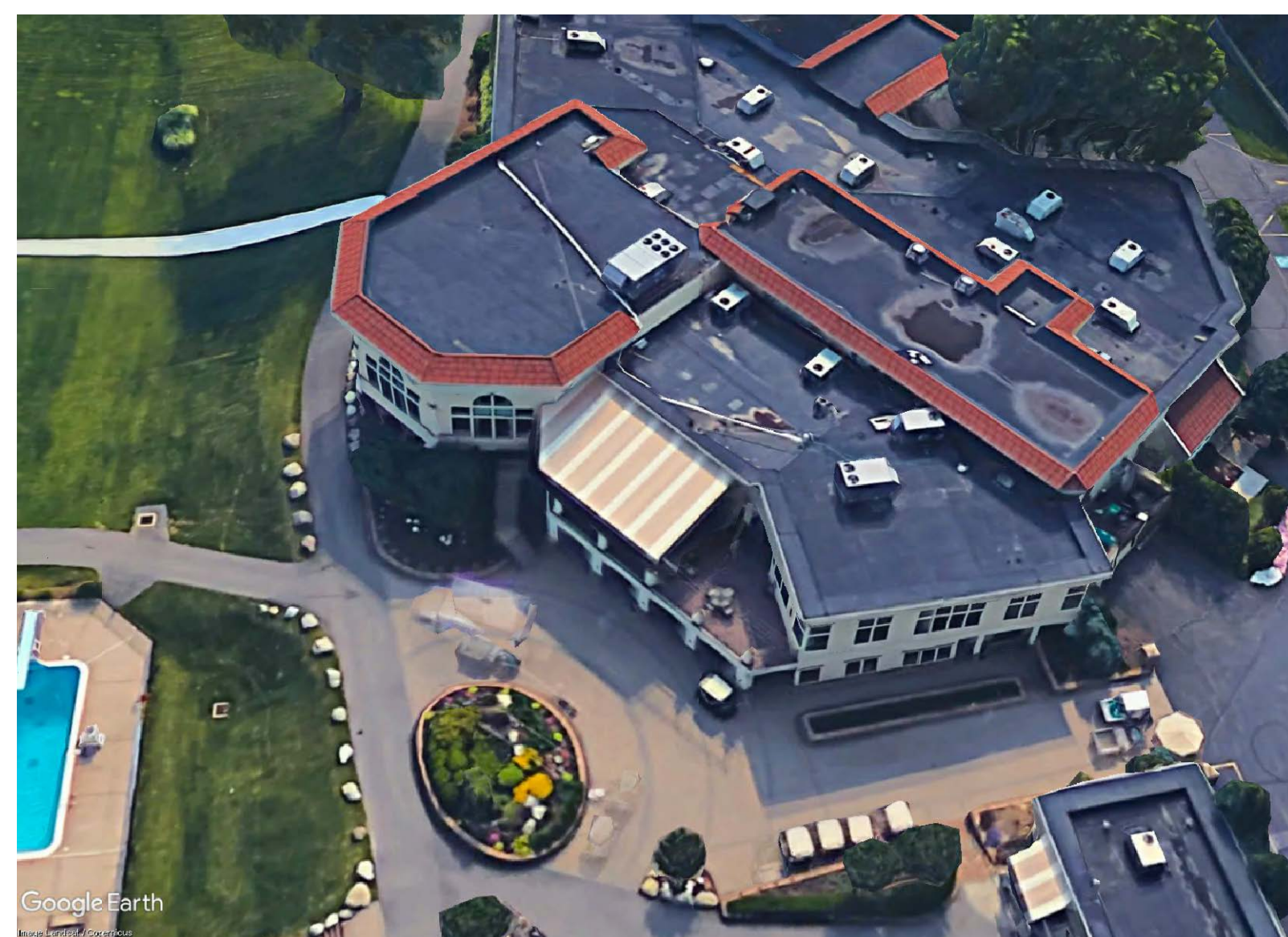
EXISTING ROOF VIEW SCALE: N.T.S.
